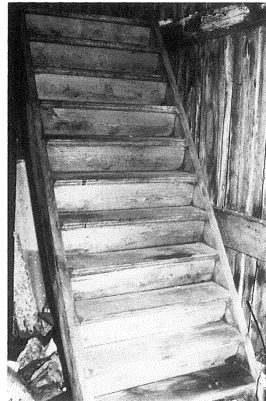
Trappa opp til prekestolen. Byggmester Hovde bygde på østdelen av huset i Kirkenesgården til bolig for arbeidsfolket sitt. Han brukte materialer fra gammelkirka til dette.
